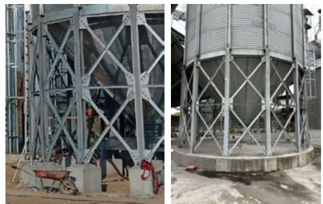
Silo fondo cónico con diseño sismo-resistente
